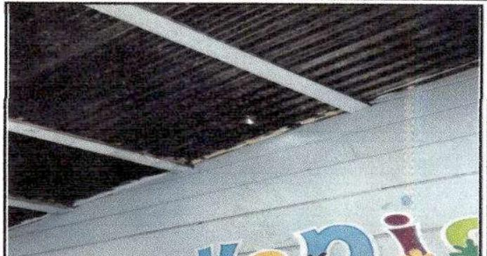
Foto 2: Sustitución de Capote de lámina para lámina troquelada, sustitución de elementos de fijación.
