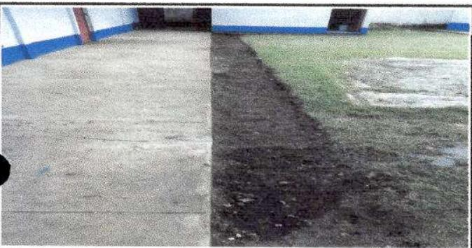
Foto 5: Sustitución de cuneta en terreno natural por cuneta de concreto.
